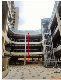
广告牌安装位置
