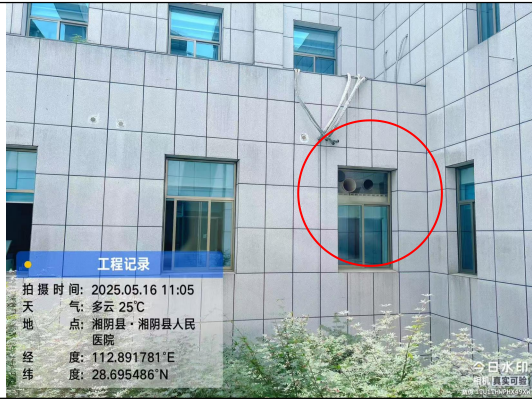
检验废气排气筒（现有住院楼）
