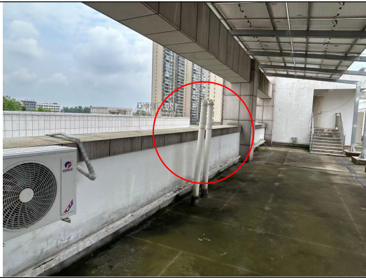
检验废气排气筒（现有住院楼）
