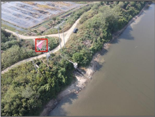
9、泥罗口机埠（原址拆除重建）施工区设置于泵站南侧空地,约 30m 2
