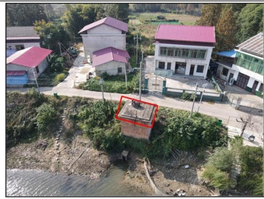
10、中兴八组机埠（更换设备），不设置施工区
