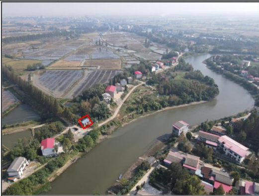
11、中兴九组机埠（更换设备），不设置施工区
