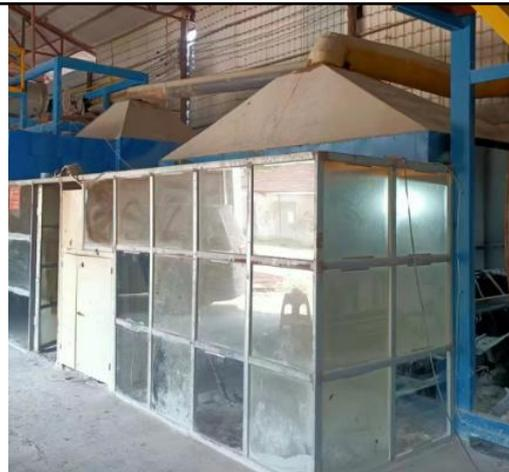
浸涂工序密闭式收集罩+集气收集系统
