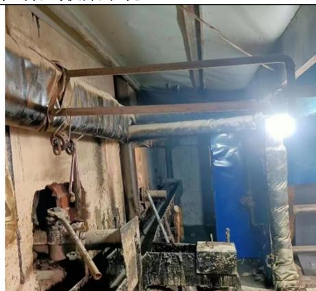
加热废气密闭收集管道+收集区域系统
