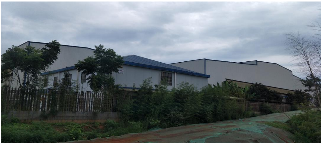
项目地西北面（众钧科技）
